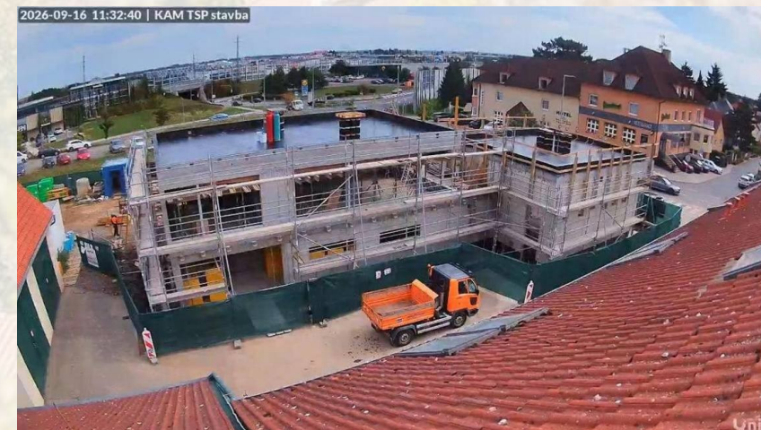
65 · Hasičská zbrojnice ve výstavbě
