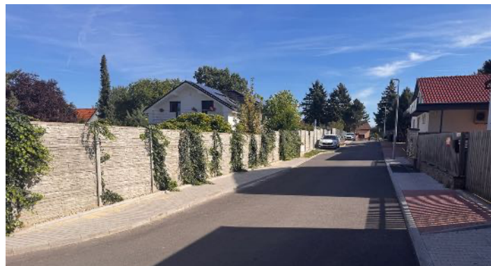
Rekonstruovaná ulice Lipová — celkový pohled
